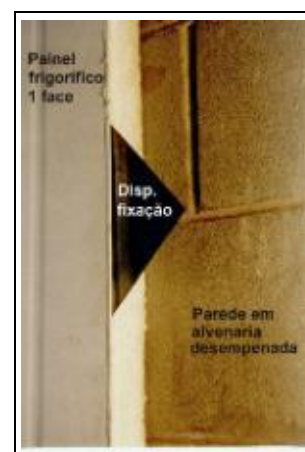
Detalhe da fixação painel 1 face para Adega climatizada personalizada
